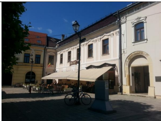
Figura 2.7.5.: Clădire reabilitată prin proiectul din anul 2004
